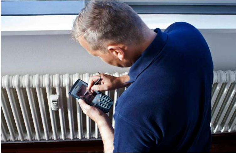
Un técnico comprueba la lectura de un calorímetro instalado en un radiador de una vivienda. | EL MUNDO
